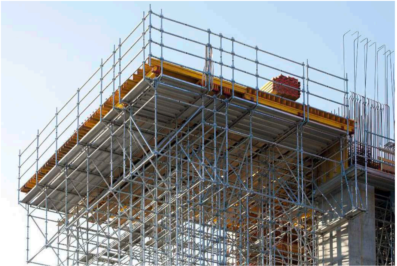
Soporte de Losa con Andamio AMD Multidireccional. 2015
