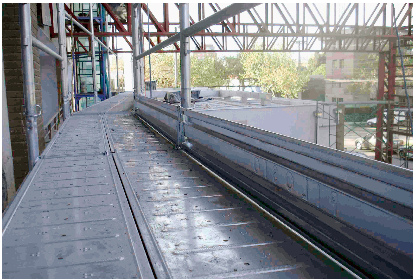
Plataforma de tránsito. Andamio AM72 Fachada. Providencia. 2011
