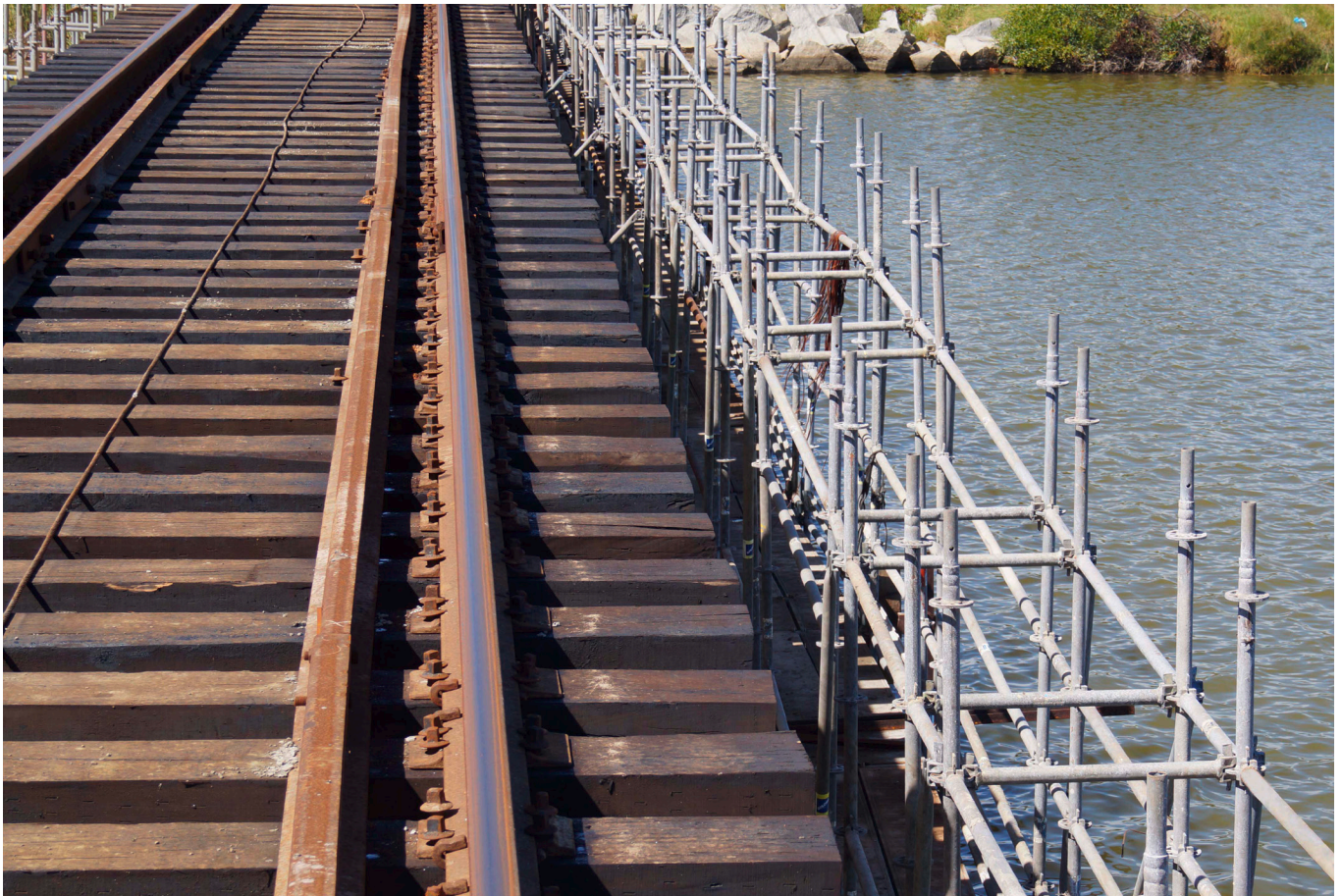
Andamio AMD Multidireccional. Puente ferroviario. 2017
